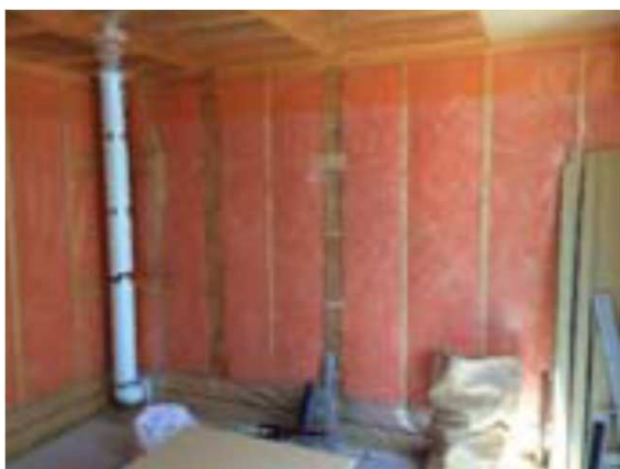
断熱材の敷設
