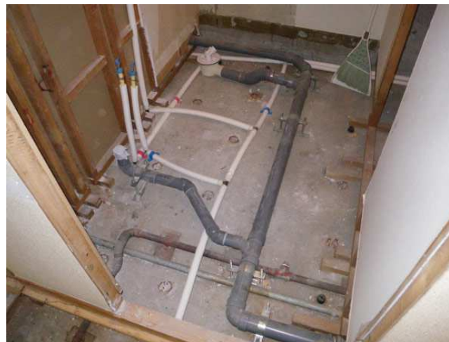
排水管の入替
