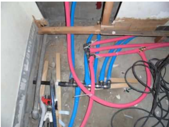
給水管の入替
