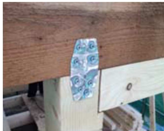
耐震金物の取付
