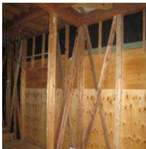
筋交いの設置
