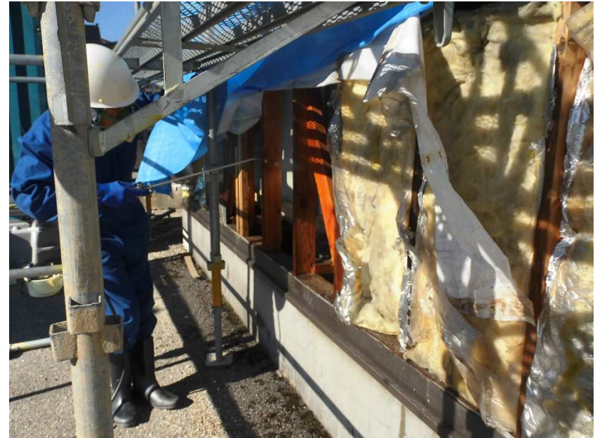
防蟻処理の様子
